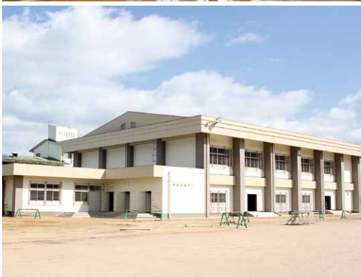
平成24年度 保育所・学校施設の耐震化等工事
