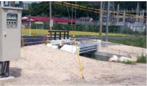
府鳥取川河川改修に伴う下水道管移設工事
