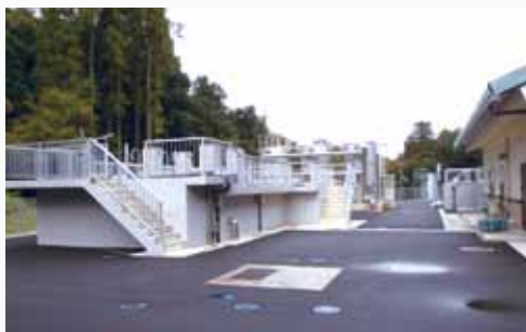
改良工事を完了した善王寺浄水場
