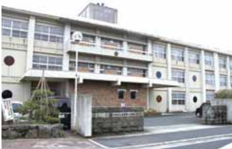
エレベーター棟の増築工事を予定する大宮第一小学校
