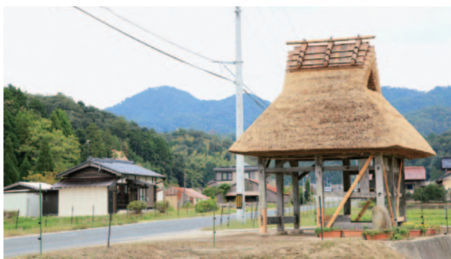
▲屋根がふき替わり、堂々とお目見えした通り堂
