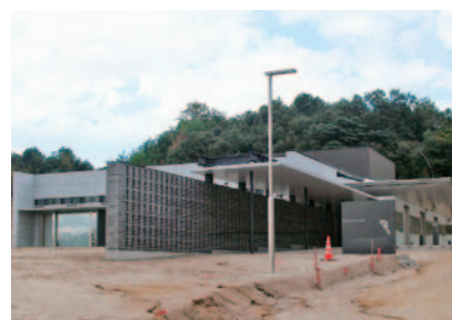
本体建築工事を終え、平成27年4月に供用開始予定の新火葬場
