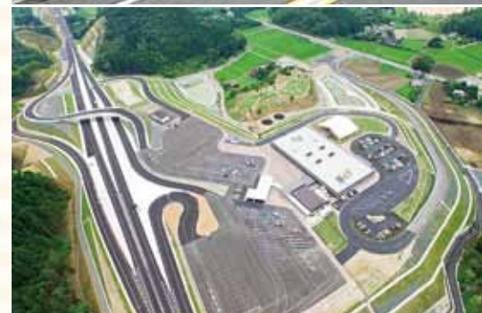
上：開通した縦貫道（広野トンネル付近） 下：京丹波パーキングエリア全景
