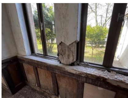
講堂柱の現状
