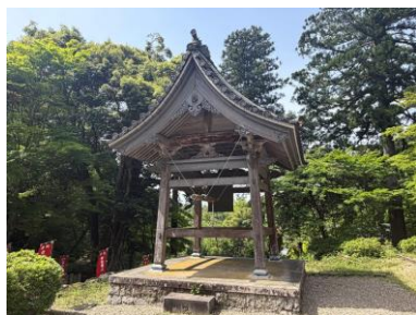
鐘楼 19世紀中頃の建立と推定される。装飾的な彫刻を施した入母屋造の鐘楼。
