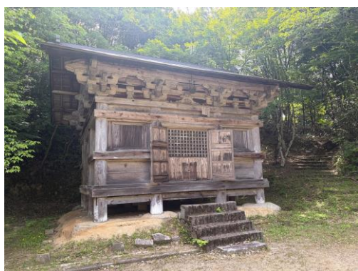
多宝塔 上層を失うが、残る下層は規模が大きく、木割の太い部材を用いる。
