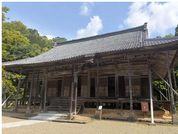
本堂 弘化3年(1846)の再建。前面に虹梁三斗を掛け、内陣の三方に入側を巡らす、丹後地域屈指の規模を誇る本格的な仏堂。
