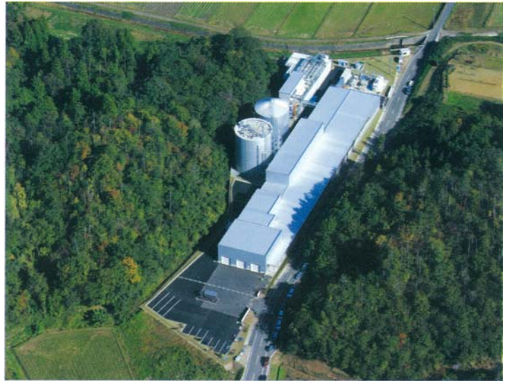
図 3-11-4 バイオガス発電施設(京丹後市)
