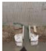
水路と水田との接続部
