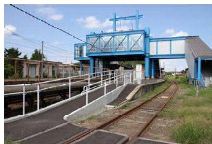
進入通路とスロープが設置された峰山駅東口
