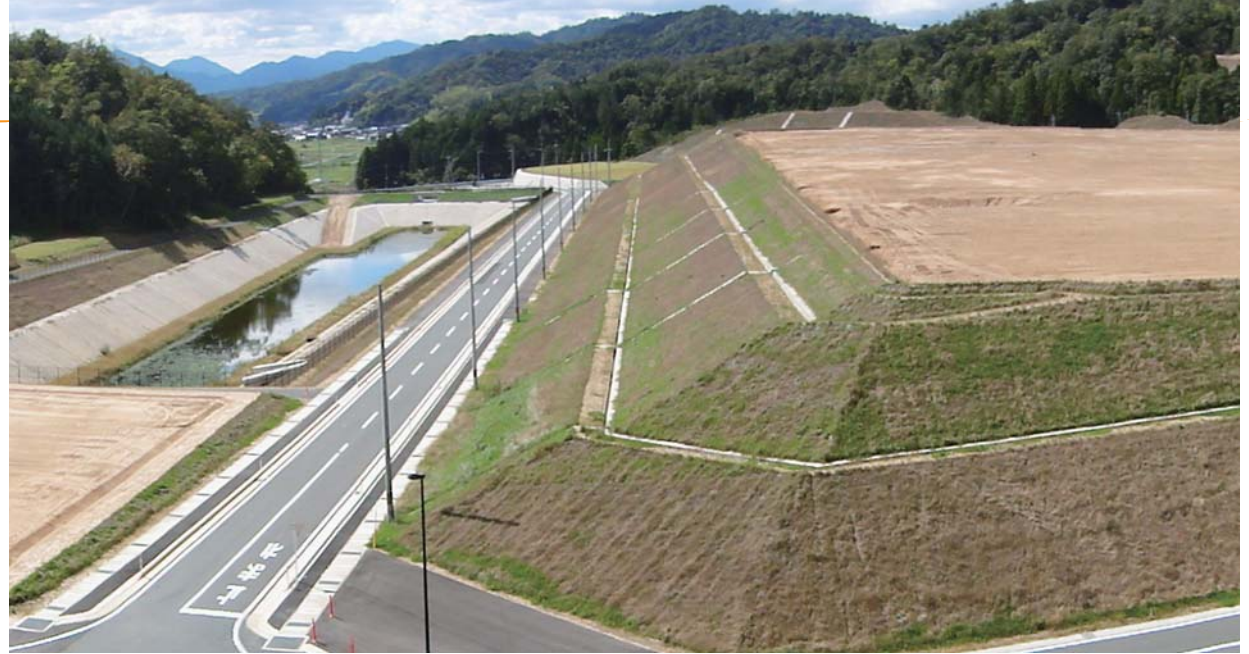
完成した森本工業団地
