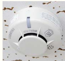
住宅用火災警報器。ドライバー1本で簡単に取り付けられます
