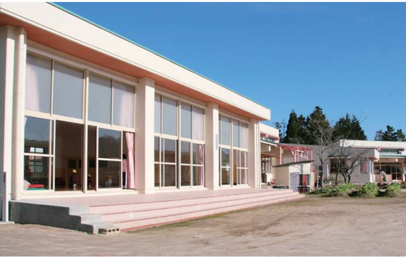
全面改修を実施した久美浜保育所（12月6日撮影）
