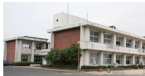
教室棟と体育館の耐震化事業に着手（鳥取小学校＝弥栄町＝）
