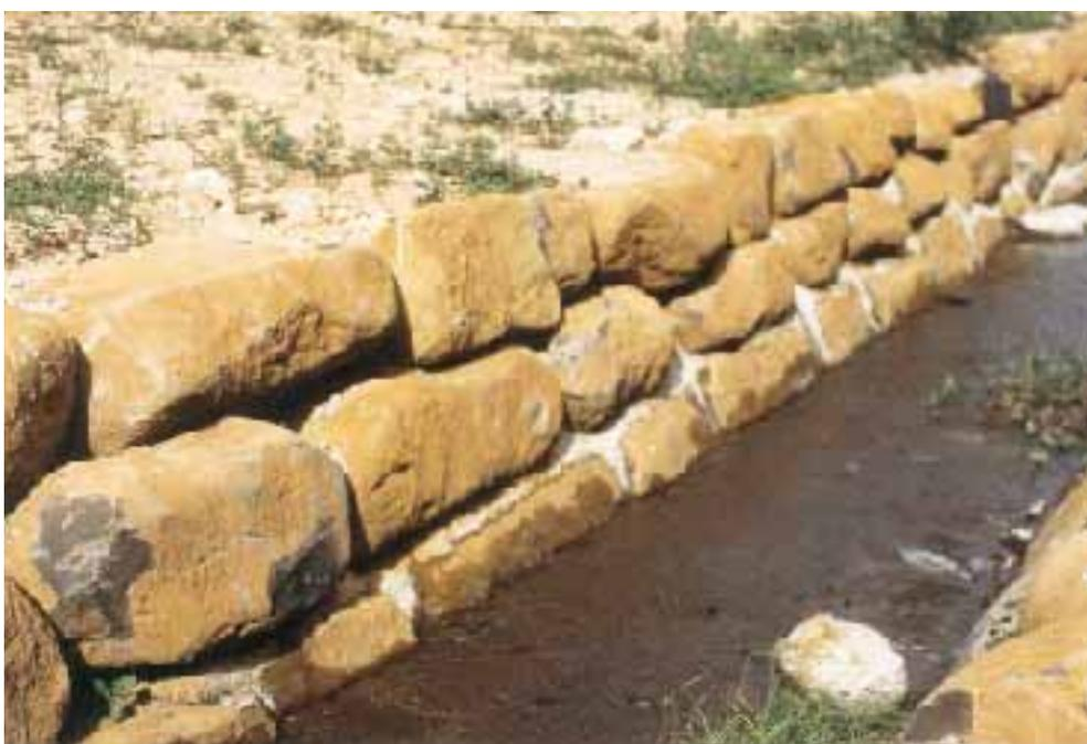
第12図 表面鉄サビでコーティングされた安山岩質の火山岩を用いて作られた排水溝。 (1995. 9. 21. 村田 源撮影)
