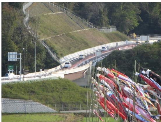
▲真新しい道路を次々と通行する車両
