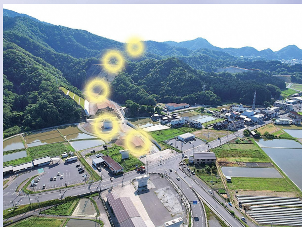
浜坂道路Ⅱ期【兵庫県】
