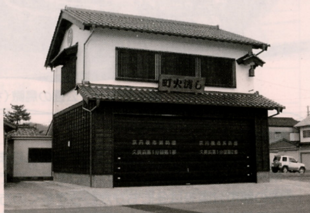
伝統的様式で建替えた消防車庫
