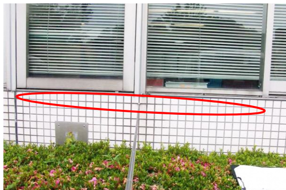
峰山庁舎(外壁)
