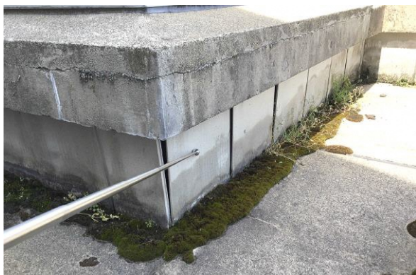
峰山庁舎(屋上防水)
