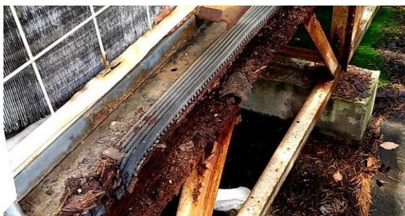
峰山庁舎(空調設備)
