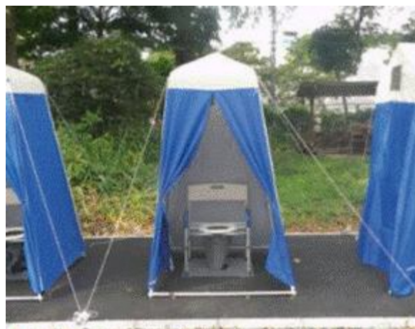
災害時用マンホールトイレシステムを設置
