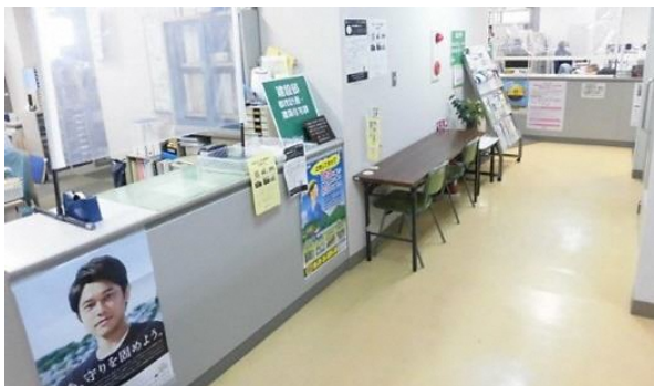
・窓口前の廊下・移動スペースが不足
