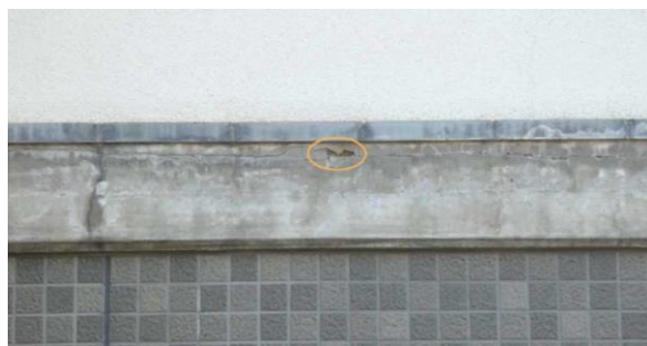
峰山総合福祉センター(外壁)
