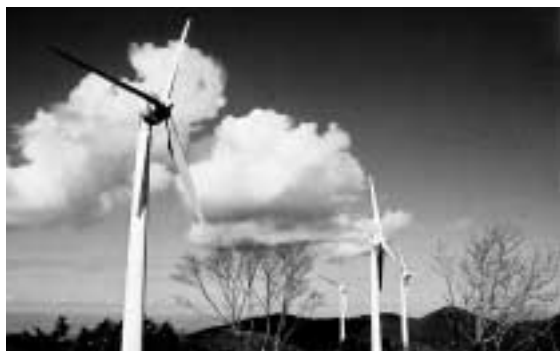
太鼓山に建設された風力発電所
