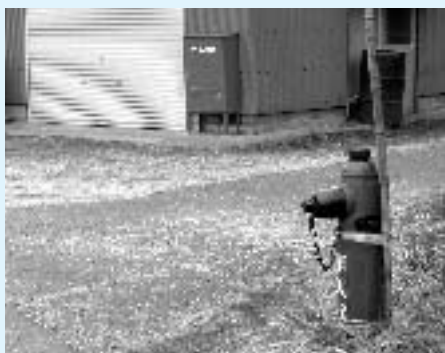
消火栓及び消火栓器具の新設・更新は全額新市負担
