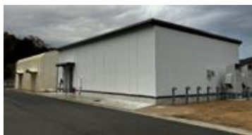
R5に竣工した干芋加工工場
