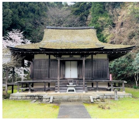
本市最古の木造建築（久美浜町） 本願寺本堂（国指定重要文化財）
