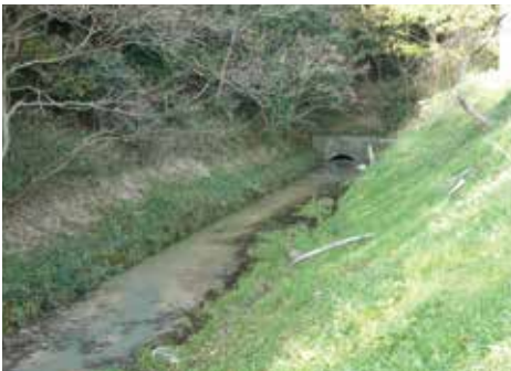
水抜穴のトンネル
