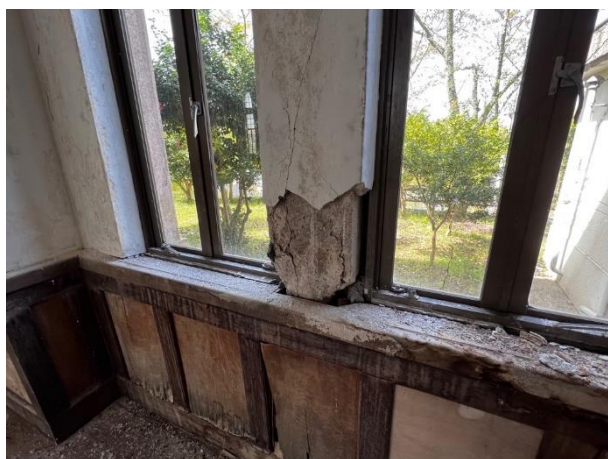
講堂柱の現状
