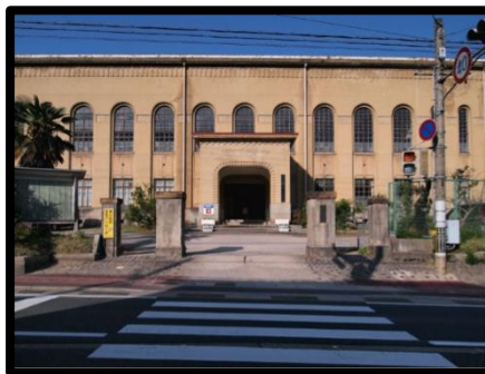
峰山小学校旧本館
