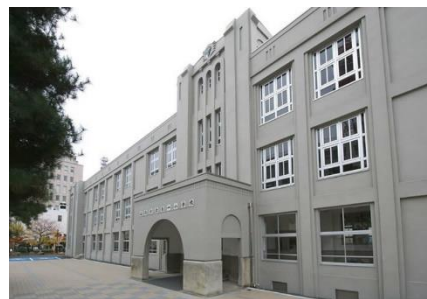
山形市立第一小学校校舎（参考⑫より）
