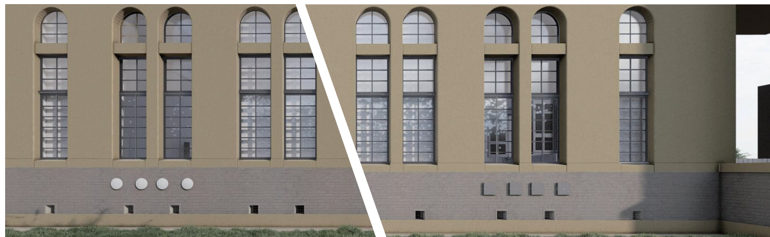
■ 外観パース 外壁に貫通する全熱交換器のキャップは意匠デザインに配慮する
