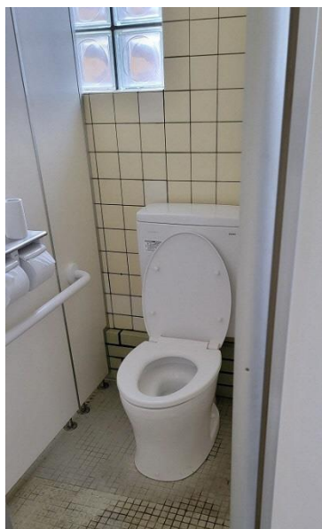
男子トイレ新設大便器
