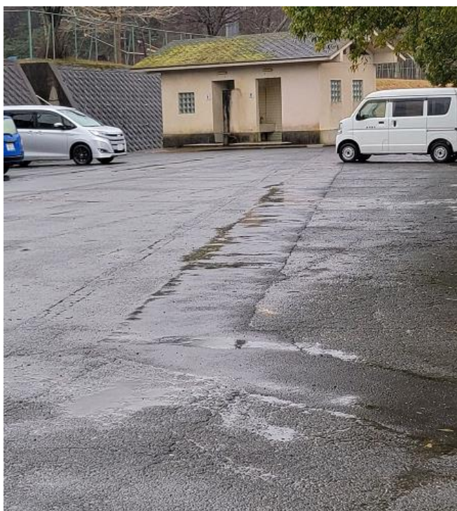
排水管・舗装復旧状況
