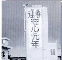
空き缶を利用した職員の手作り缶パンです 峰山消防署(本署)の訓練塔へ設置してあります
