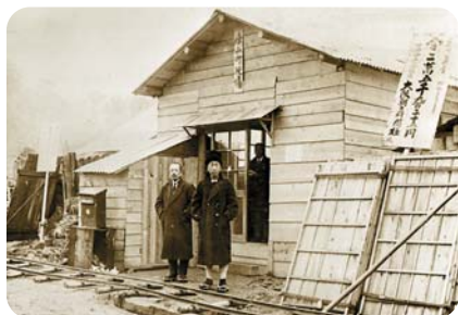
バラック建て(仮小屋)の峰山町役場
