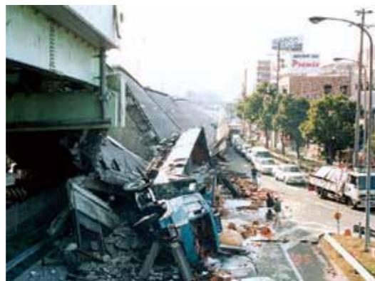
▲阪神・淡路大震災の被害状況(神戸市提供)
