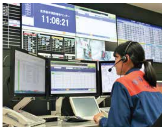
通信指令室の様子
