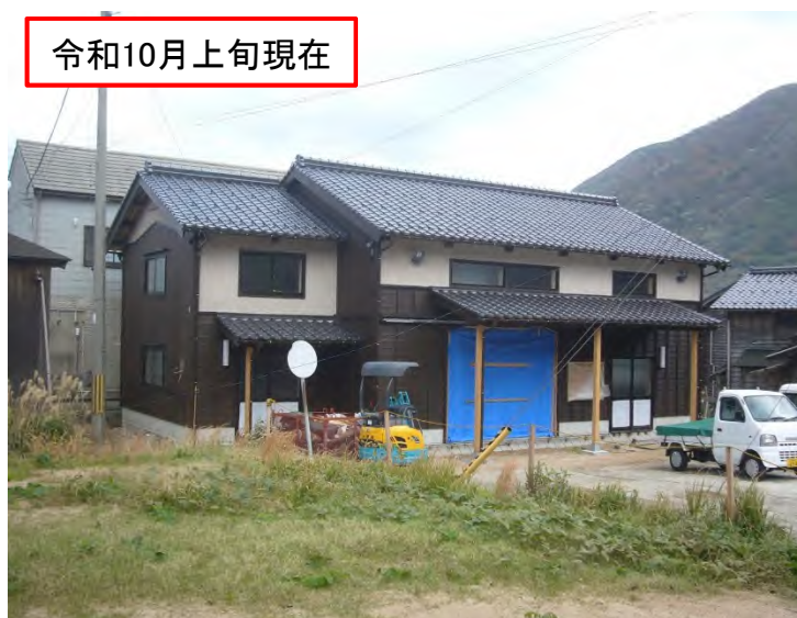
袖志コミュニティ倉庫整備事業(基金) (丹後町袖志)
