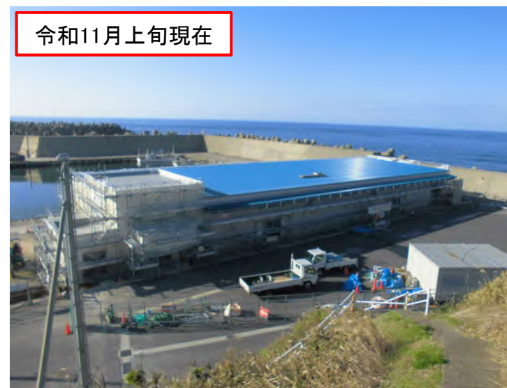
間人漁港荷捌所等整備事業(基金) (丹後町間人)
