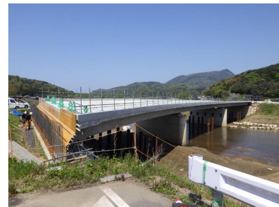
間人大宮線(大門橋右岸から撮影)
