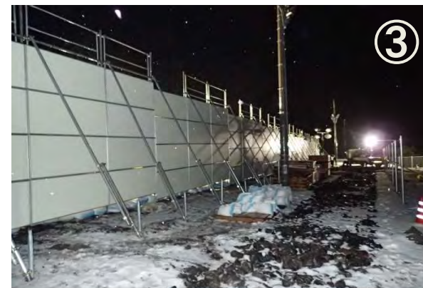
防音パネル(袖志側) (26. 12. 6設置)
