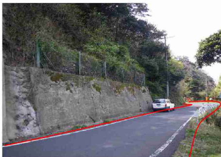
国道178号線(袖志工区)
