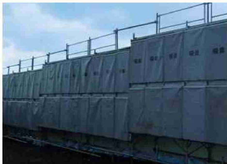
防音パネル・吸音パッド(平成26年12月設置)
