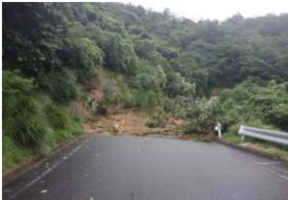
平成 30 年 7 月豪雨 (府道浜詰網野線の土砂崩れ・網野町)
