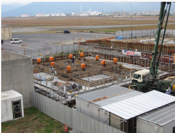
施設の建設工事の様子（イメージ）
