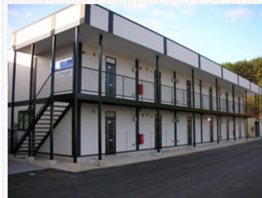
車力通信所に隣接する借上住宅
