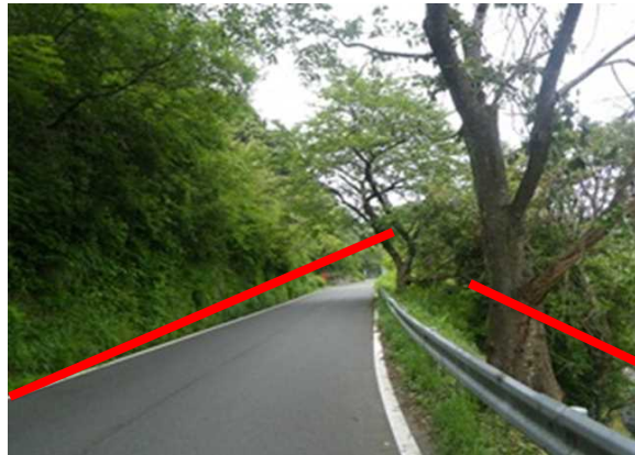
国道178号線(カマヤ工区)
