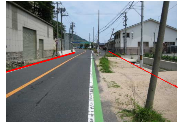
国道482号線(大山工区)
