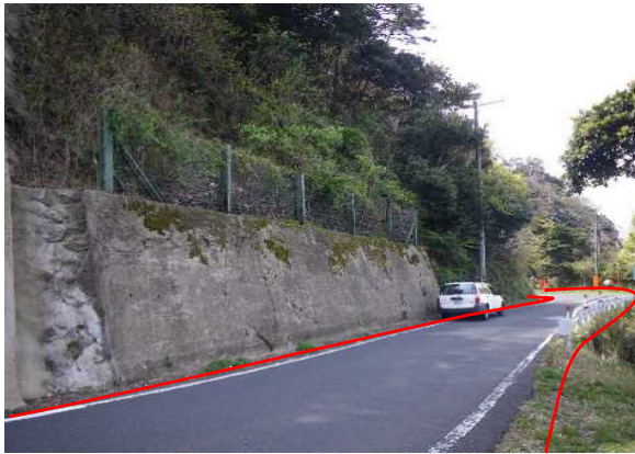
国道178号線(袖志工区)
