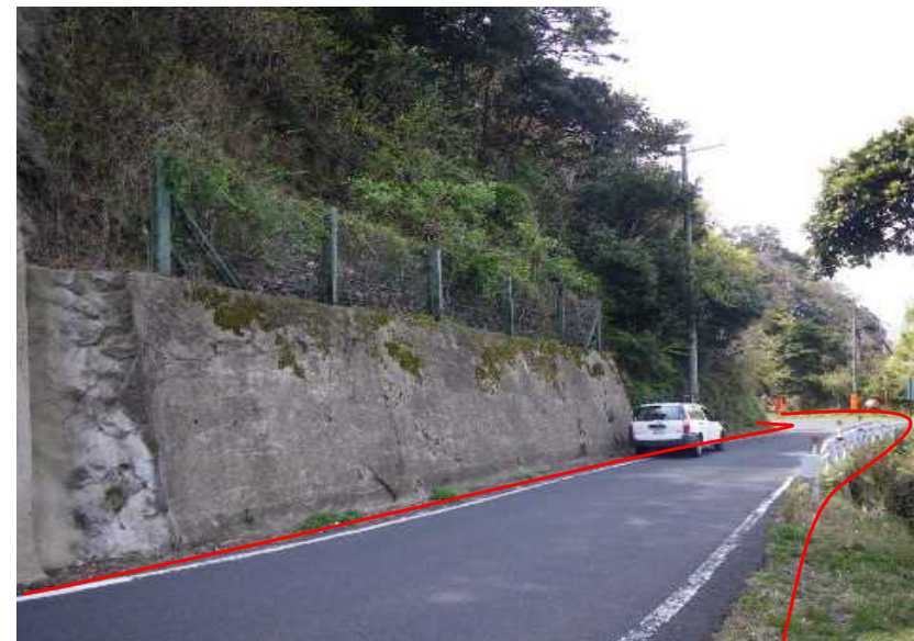
178号線(袖志工区)
