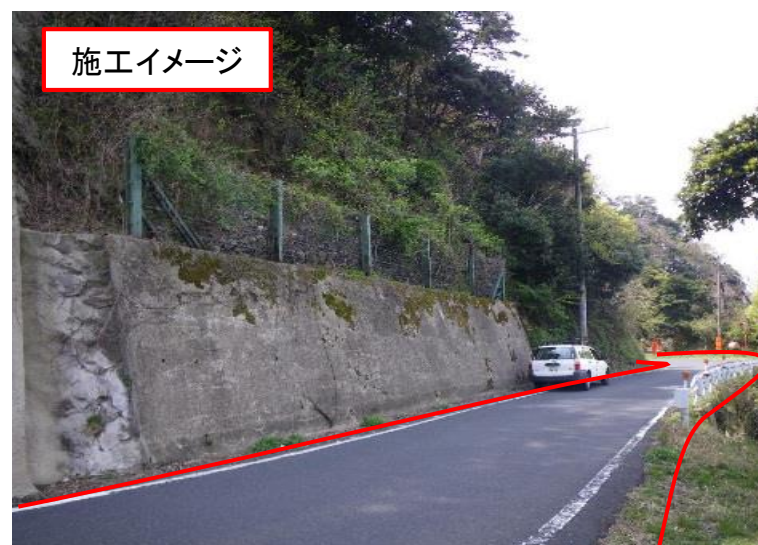
178号線(袖志工区)
