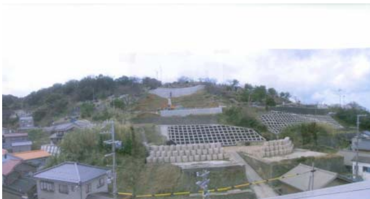
【対策工事が完成した災害現場】
