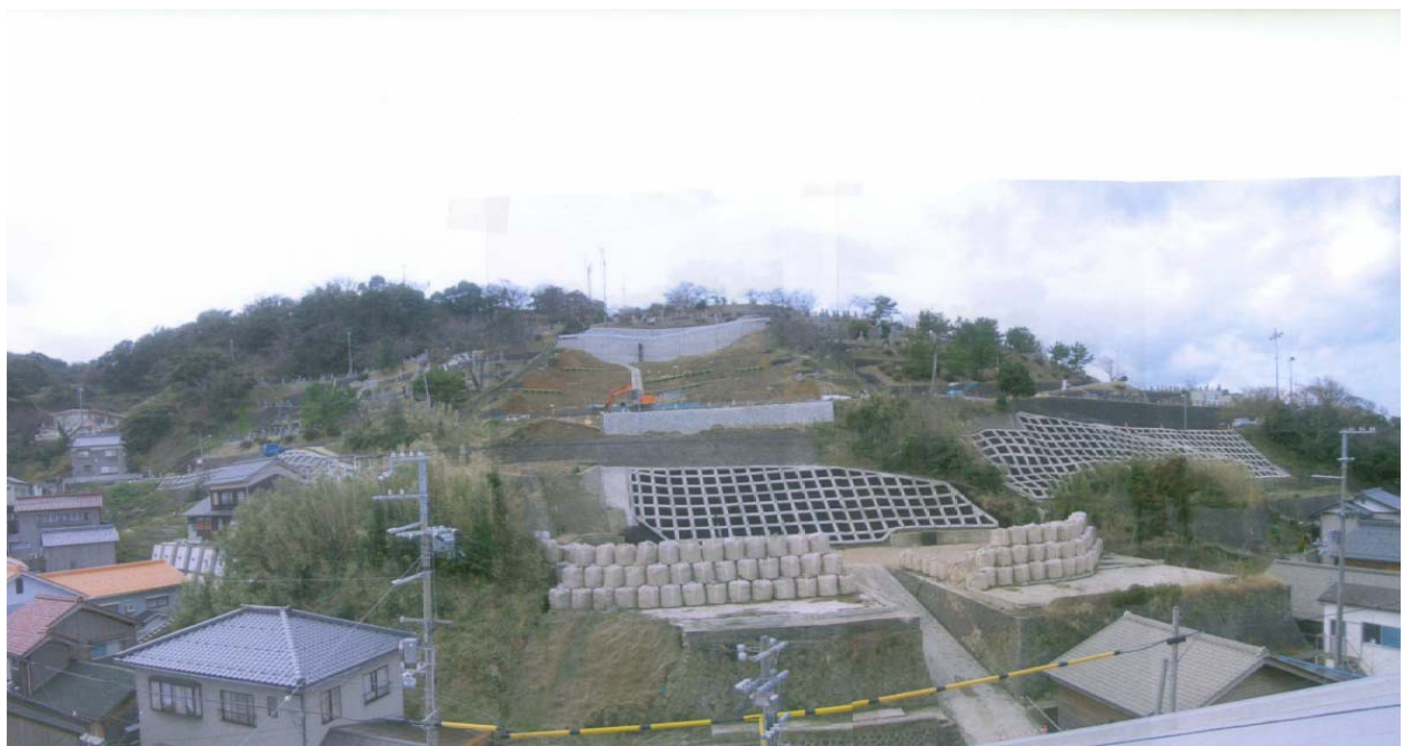
【対策工事が完成した災害現場】
