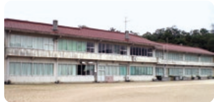
研究開発拠点となる旧溝谷小学校(弥栄町溝谷)
