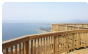
新たに設置されたかぶと山展望台
