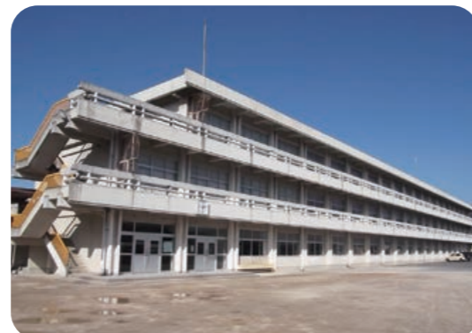
耐震補強工事とともに空調設備を整備する峰山中学校校舎
