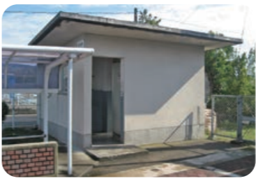
改修予定の峰山駅西口のトイレ
